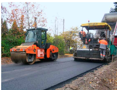
5 pav. Asfalto dangos įrengimas iš šiltojo asfalto mišinio kelyje Nr. 4007 Kairiai–Narušaičiai–Dagučiai
