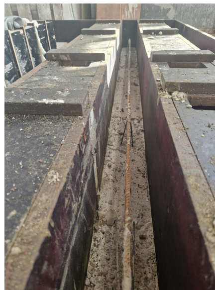
4 paveikslas. Nevalytas elemento jungties paviršius
