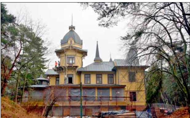
16 pav. Restauruojama „Anapilio“ vila (A. Jankauskaitės nuotr. 2015)
