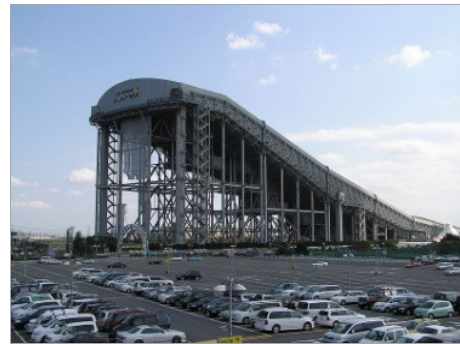
4 pav. Skidome uždara slidinėjimo trasa, Chiba, Japonija
