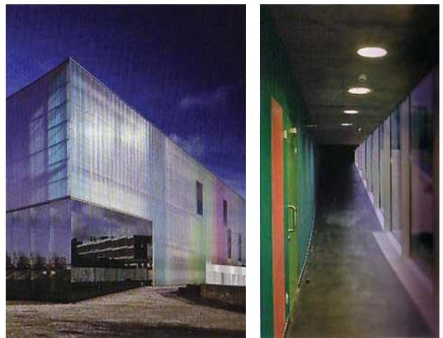
4 pav. Laban šokio centras. Archit. Herzog ir De Meuron, su jais bendradarbiavo dailininkas M. Craig-Martinu, Londonas, 2003 m.
