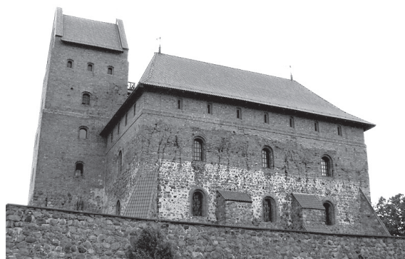
2 pav. Atstatytų Trakų salos pilies rezidencinių rūmų ir donžono rytinis fasadas
