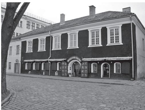
13 pav. Zabielių rūmai Kaune. Restauruotas šiaurės (pagrindinis) fasadas
