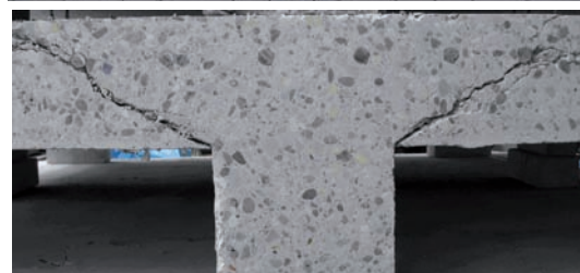
5 pav. Plokštės PP-20.1 viršutinio paviršiaus plyšiai ir praspaudimo kugis
